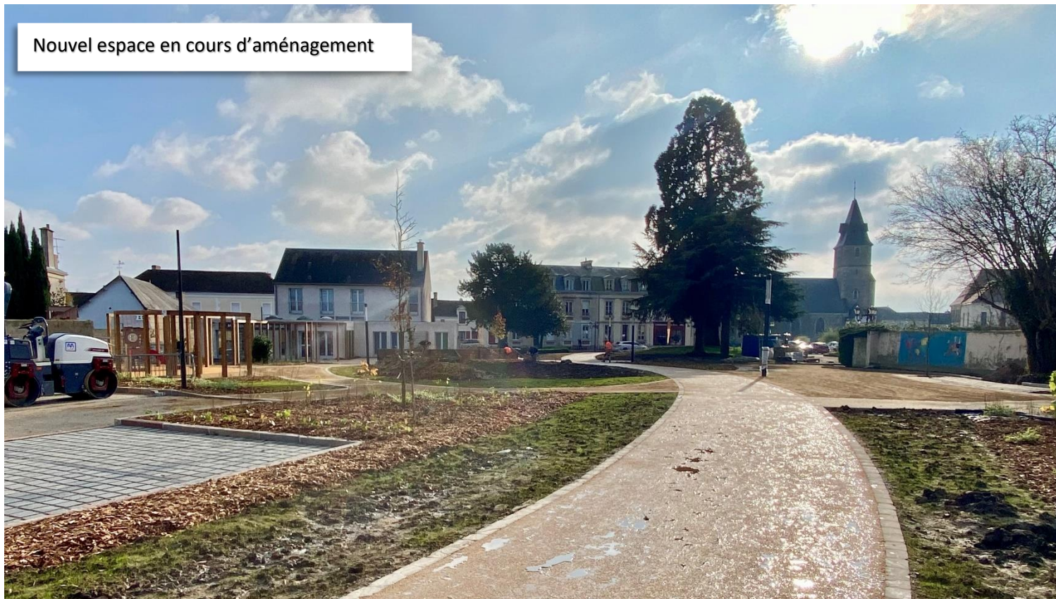
Aménagement en cours devant la maison des associations
