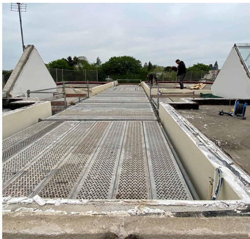
La verrière a été déposée et la charpente est en cours de fabrication
