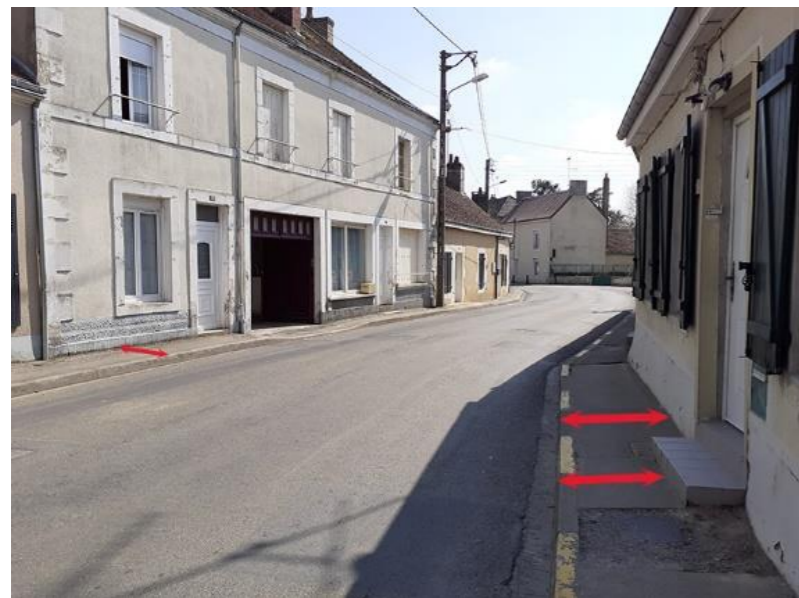
Trottoir étroit encombré par des supports de réseaux et des marches
